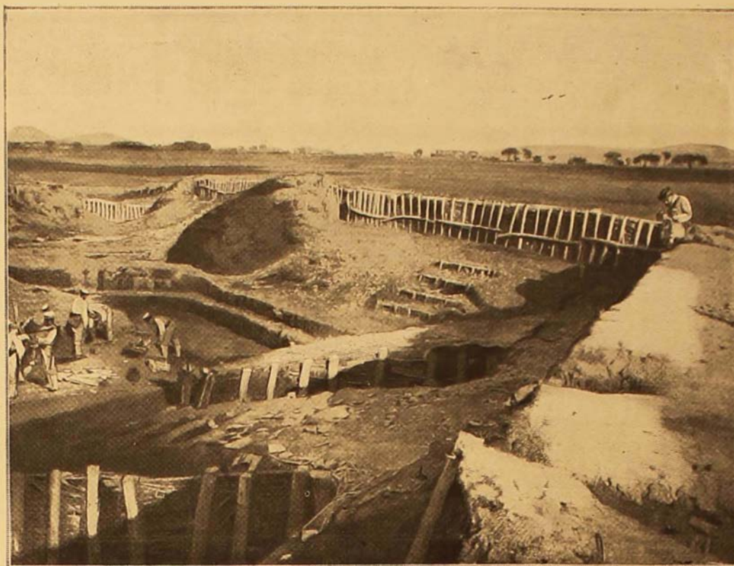
Parapets et revêtement.
