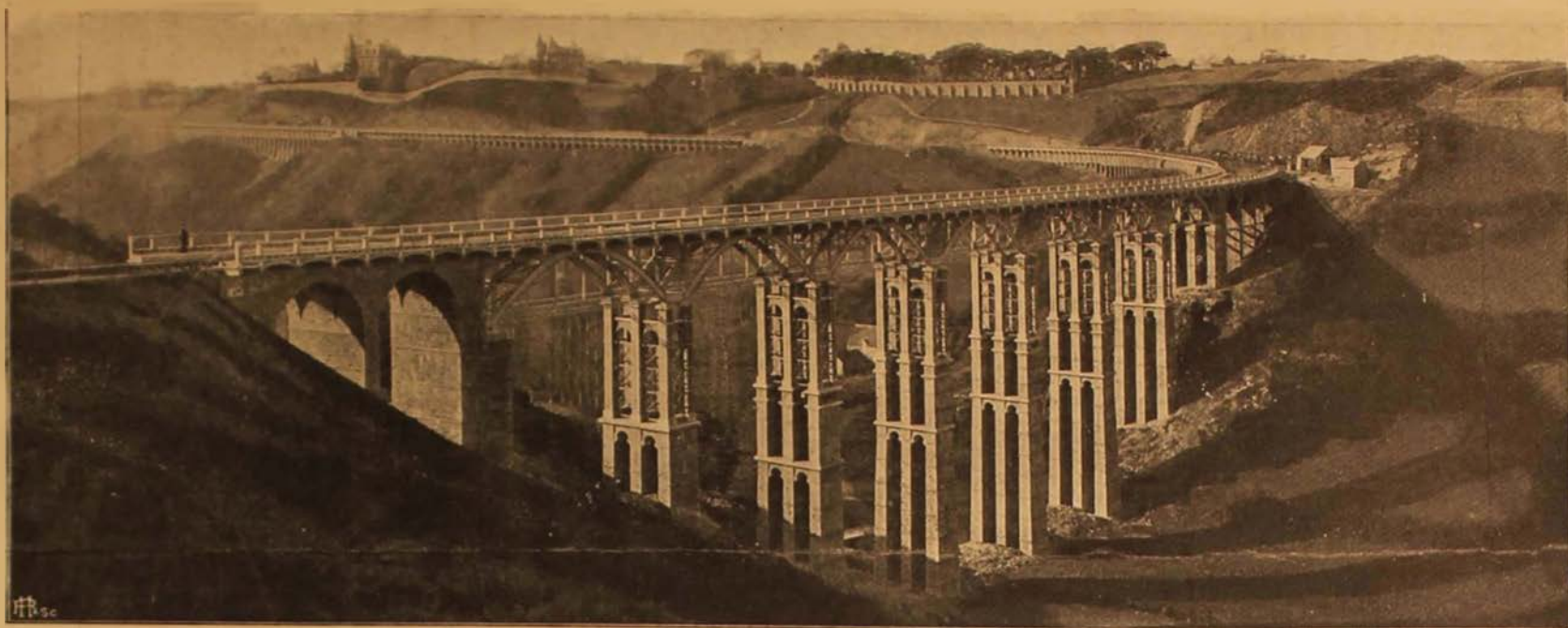
LE VIADUC DE TOUPIN (179 mètres de long, 35 mètres de haut) : au fond, les nouveaux boulevards de Saint-Brieuc.
