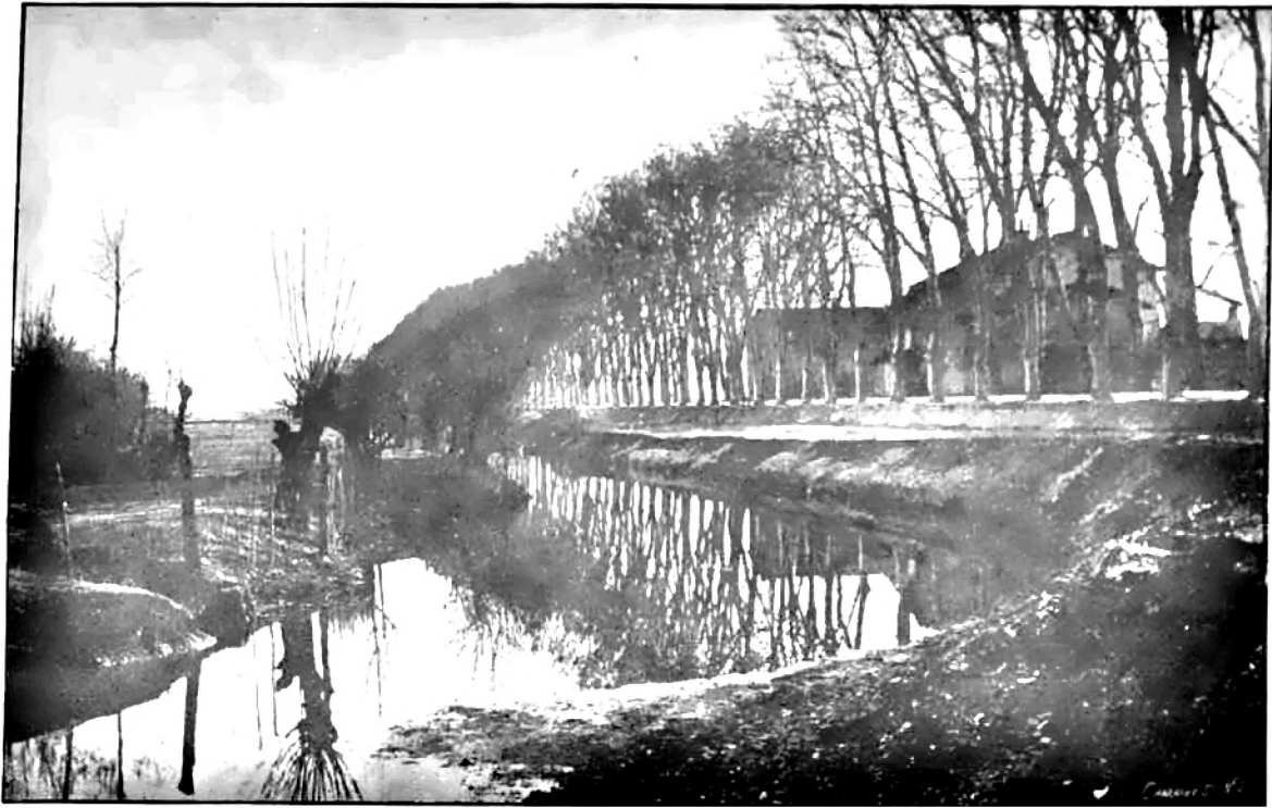
Avenue du port. — Photographies de M. Dotta.
