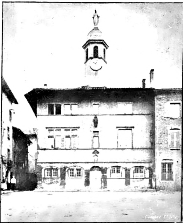
Façade principale du Collège de Thoissey.
