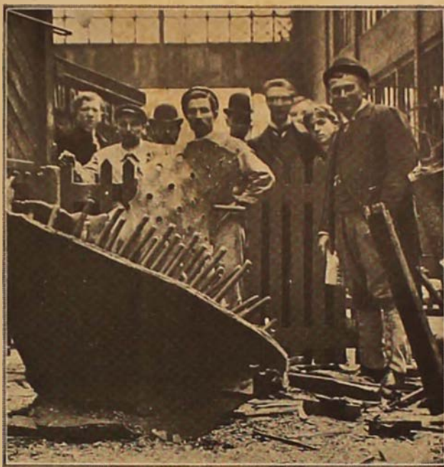
Un des fragments de la chaudière retombé sur la voie.
