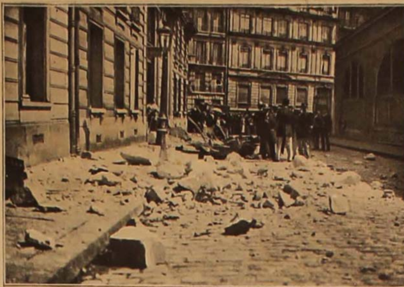
Les débris de la façade du n° 4 de la rue de Berne.
