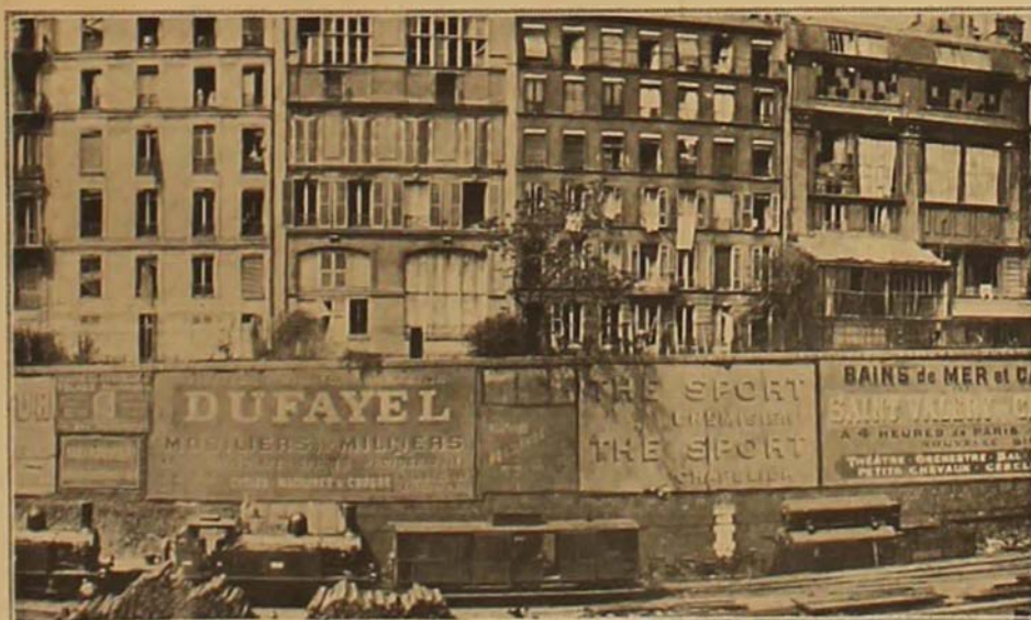
Fenêtres de la façade postérieure des maisons de la rue de Rome, après l'explosion.
