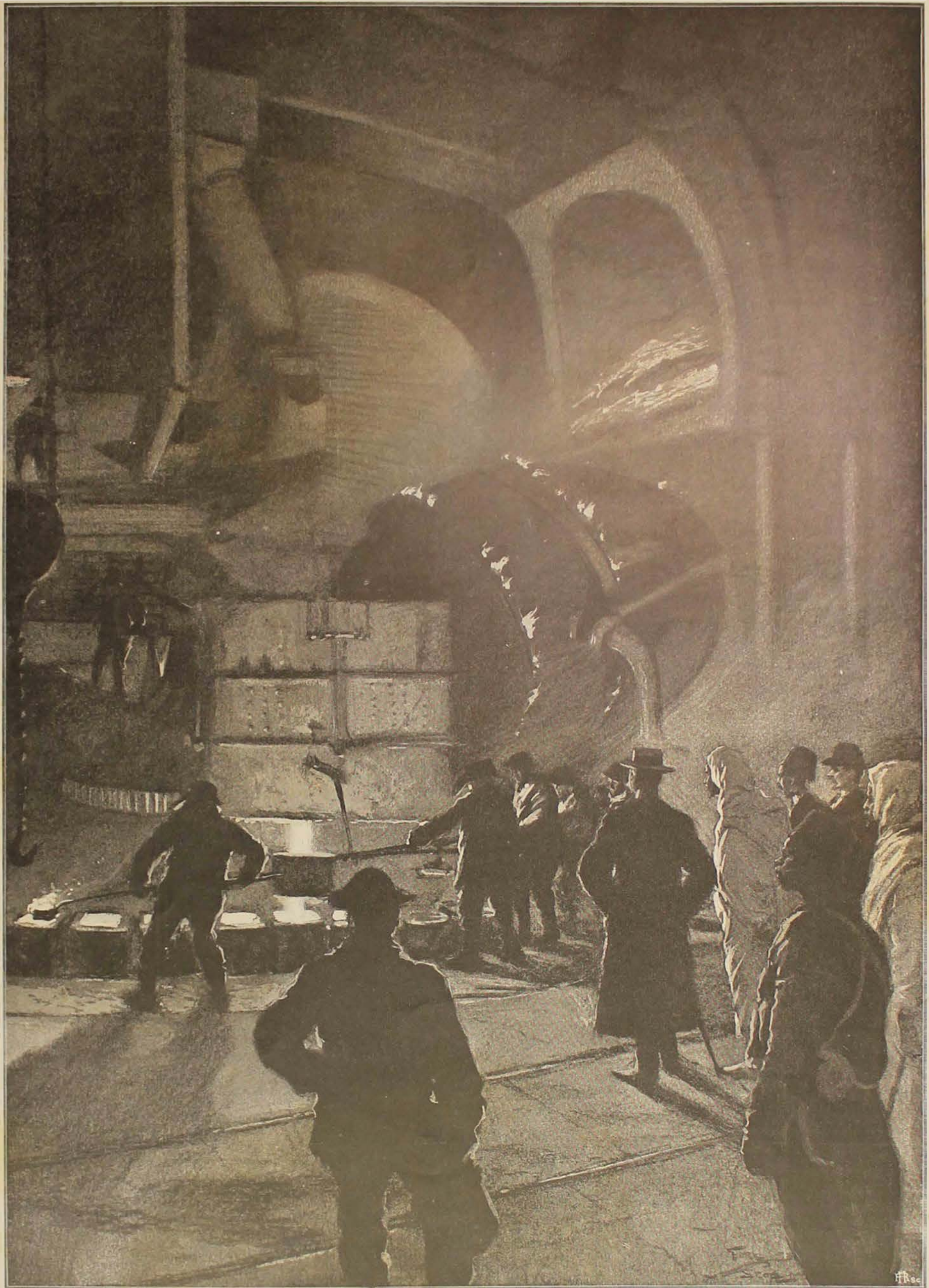
EL MENEBHI, MINISTRE DE LA GUERRE DU MAROC, AU CREUSOT Visite nocturne aux fours Bessemer: la coulée de l'acier dans les lingotières. — Voir l'article, page 30.
