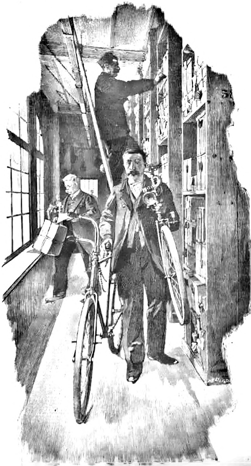
Un couloir de service, rue des Blancs-Manteaux.
