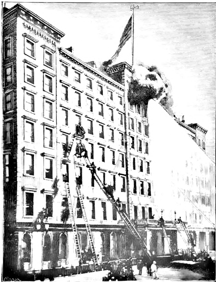
L'incendie de l'hôtel Windsor, à New-York. (Phot. prise au début du sinistre.)
