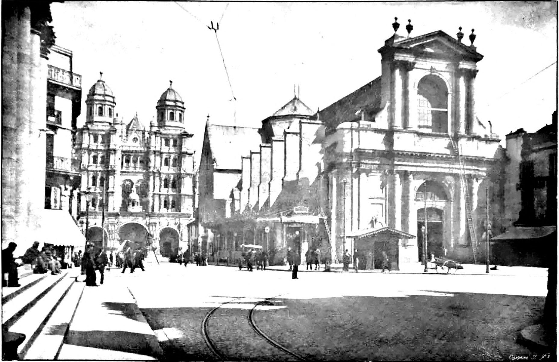
DIJON. — L'ancienne église de Saint-Étienne transformée en Bourse du commerce.
