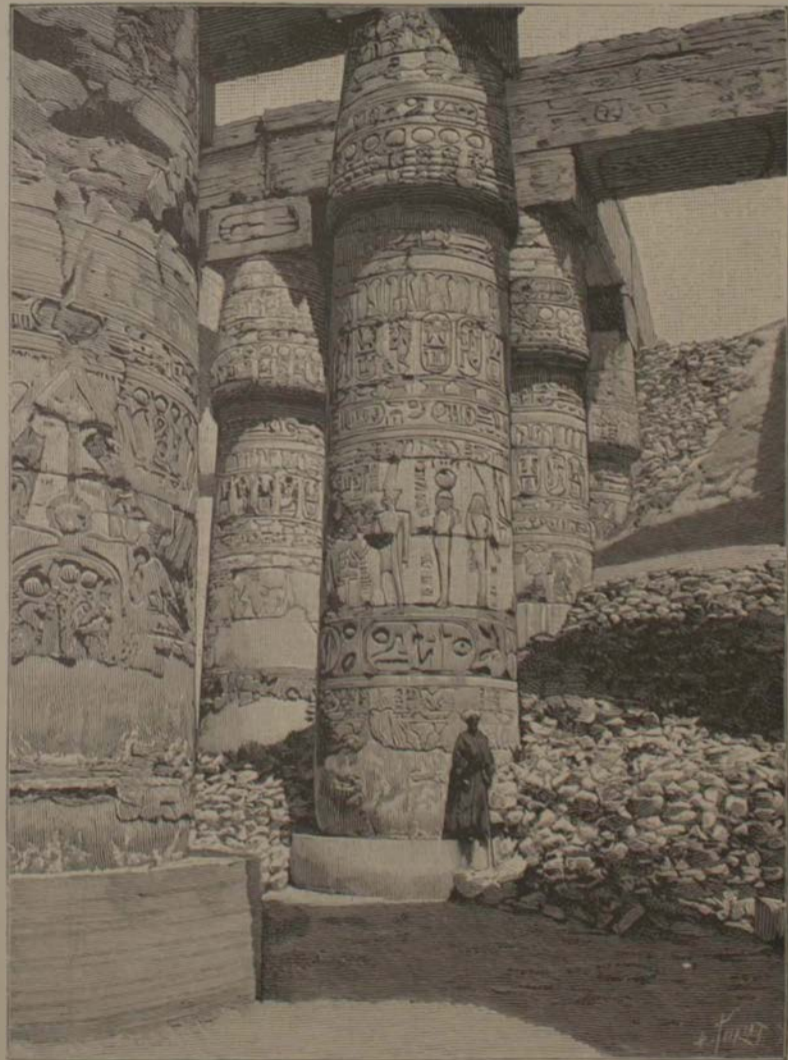
Remblai d'étai de la colonne penchée. — (Phot. Aug. André et Beato.)
