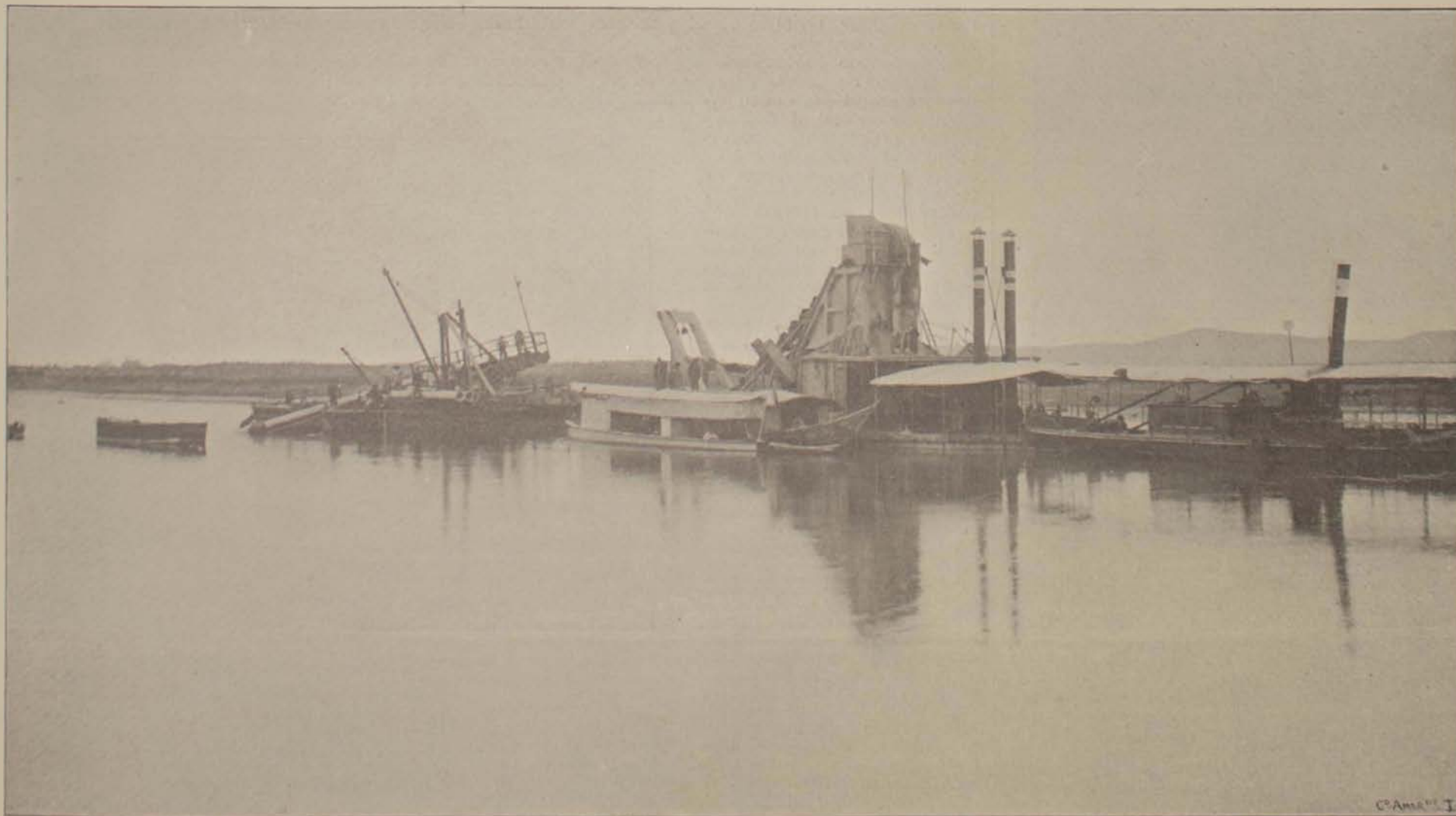
TONKIN. — La pose du siphon à rotules dans le Cua-Cam (port d'Haïphong).
