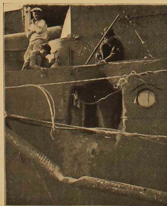
Trou produit dans le flanc de l'Askold par un obus qui, après avoir broyé la poutre du filet contre les torpilles, a éclaté dans la cabine du commissaire.
