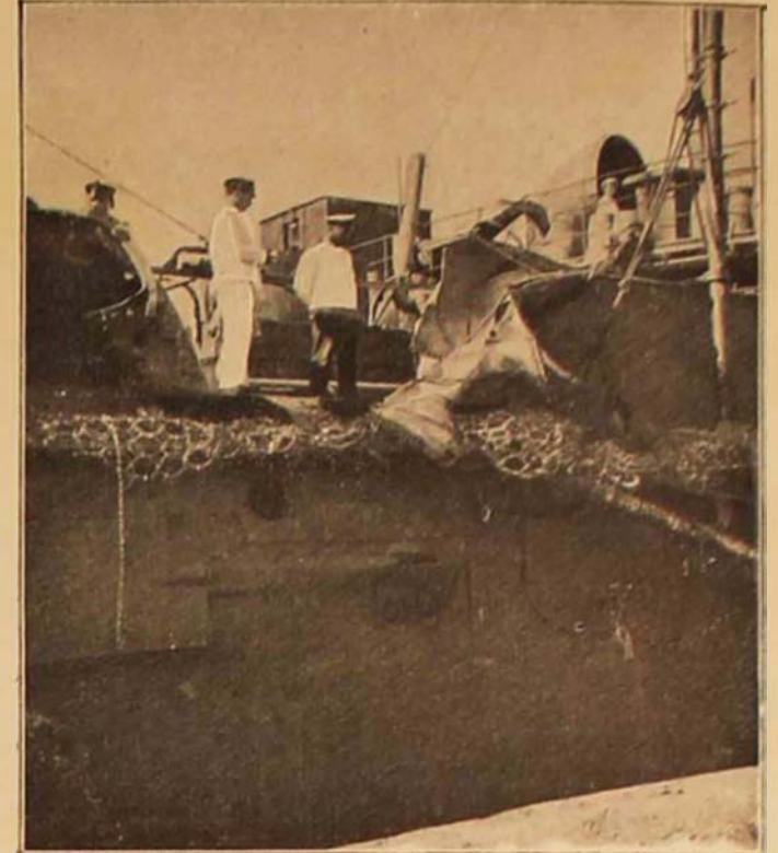
Ouverture (5 mètres de diamètre) produite par la sortie d'un obus entré de l'autre côté de l'Askold.
