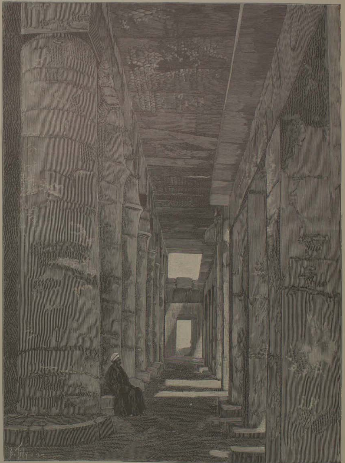
Intérieur du promenoir de Thoutmès III après le déblaiement.
