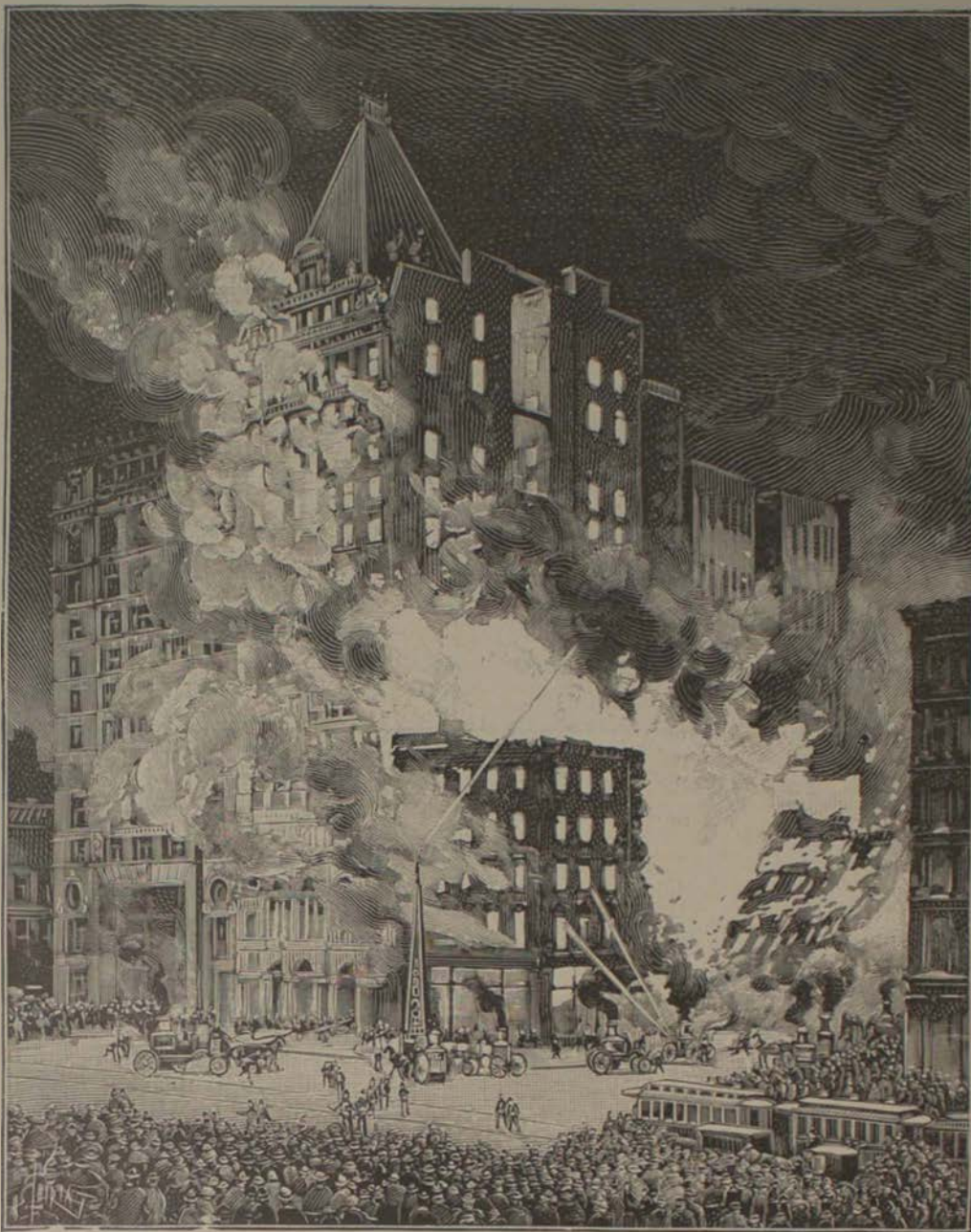
Incendie d'un immeuble de 17 étages à New-York.
