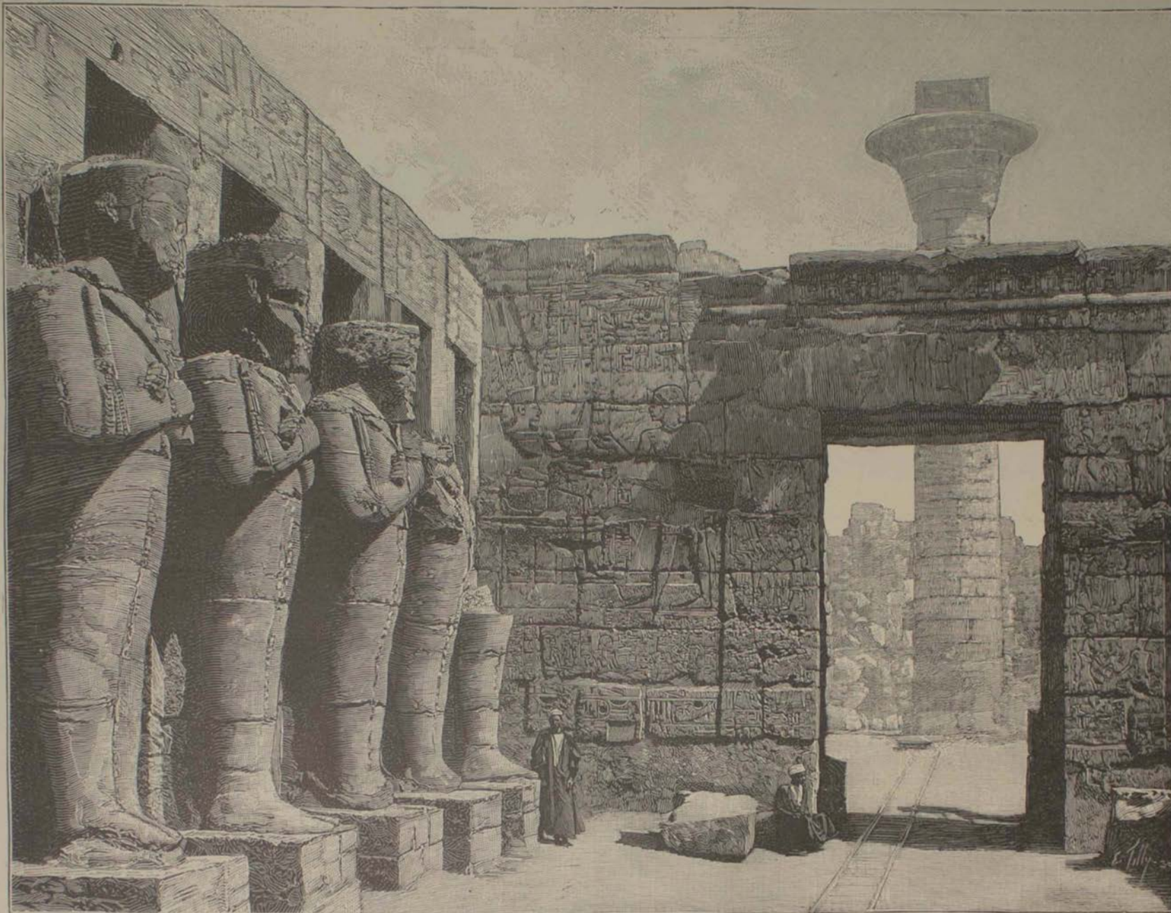
Colonne de Taraga, cour et colosses du temple de Ramsès III après le déblaiement et la restauration.
