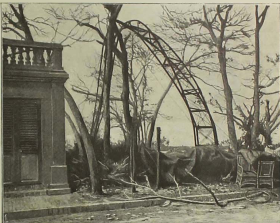
UN TYPHON EN COCHINCHINE. — Pylônes de l'administration des postes tordus par la tempête. — (Phot. comm. par M. Sambluc).
