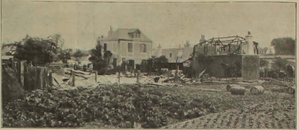
Aspect du chantier de l'entreprise Moreau après le pillage.
