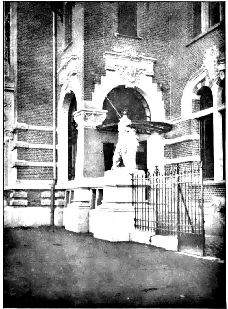
Détail d'une entrée de pavillon.
