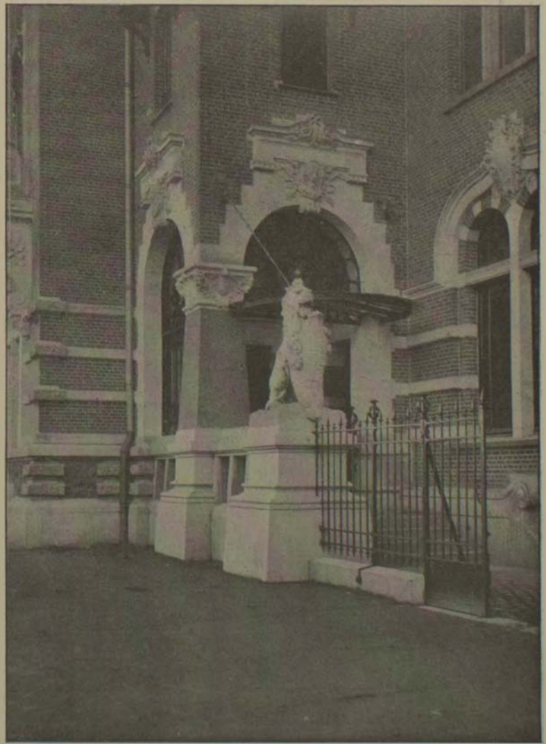
Détail d'une entrée de pavillon.
