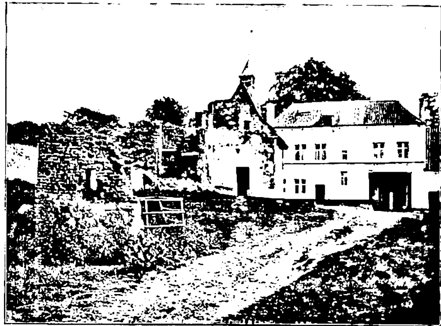
Ruines du château d'Hougoumont : état actuel.
