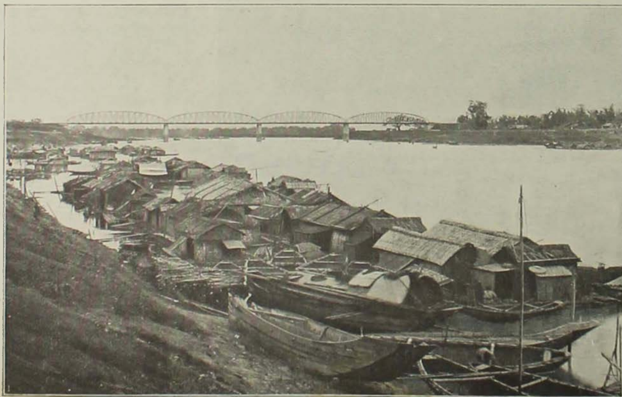
LA LIGNE D'HANOÏ AU YUN-NAN. — Pont de chemin de fer de Vietri, sur la rivière Claire.
