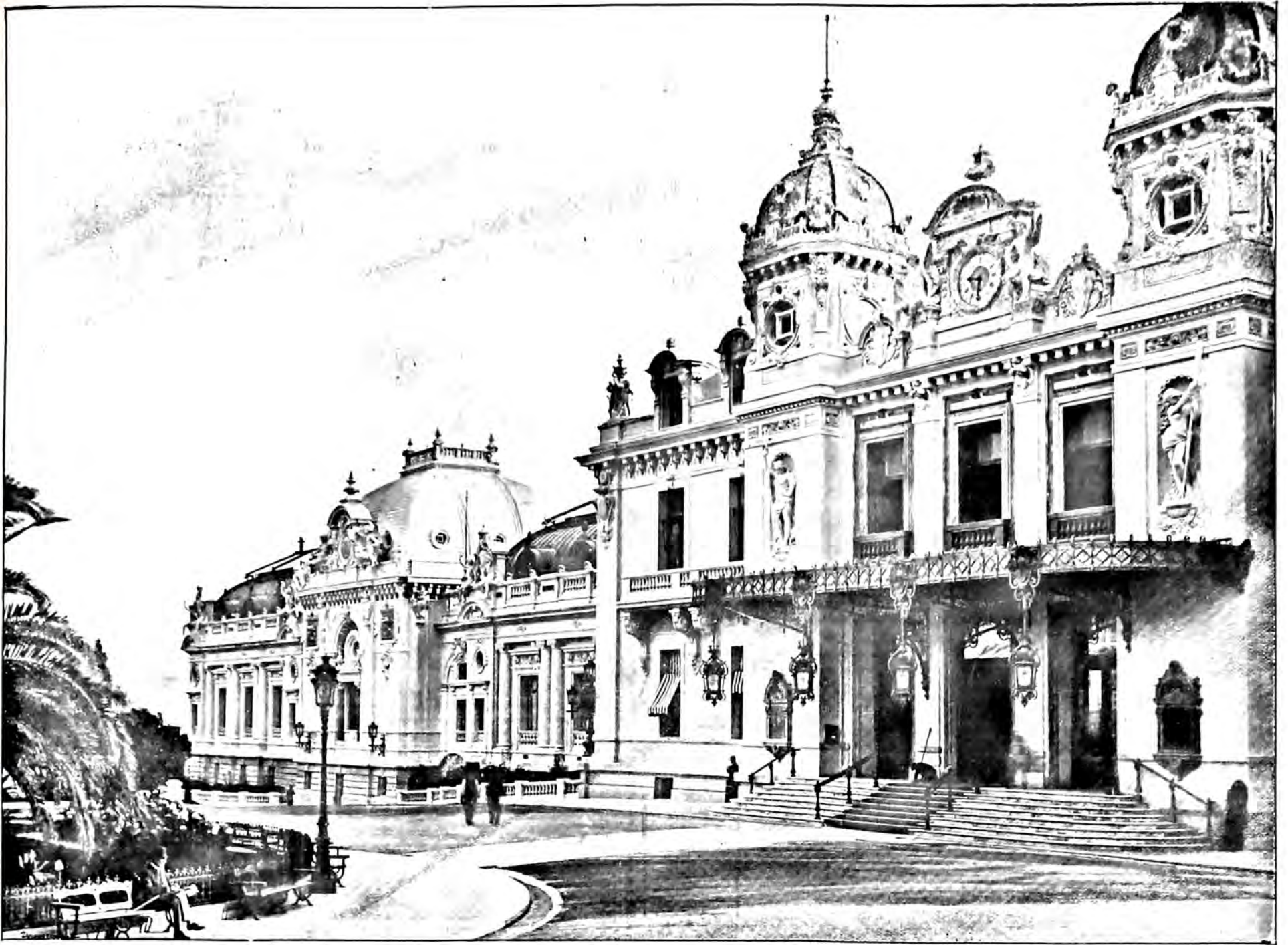
Vue de la nouvelle façade du Casino de Monte Carlo.
