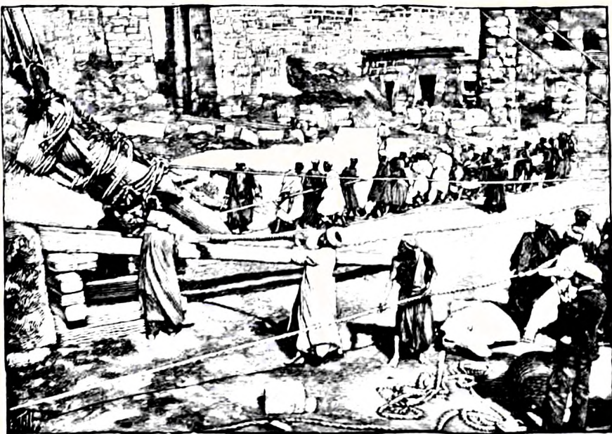
Travaux de redressement de la statue de Ramsès III.
