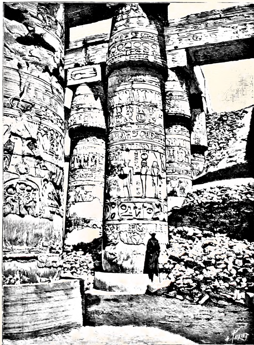
Remblai d'étais de la colonne penchée. — (Phot. Aug. André et Beato.)
