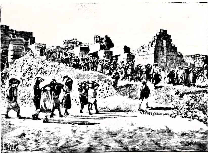
Fellahs travaillant au remblai et au plan incliné de la colonne penchée.
