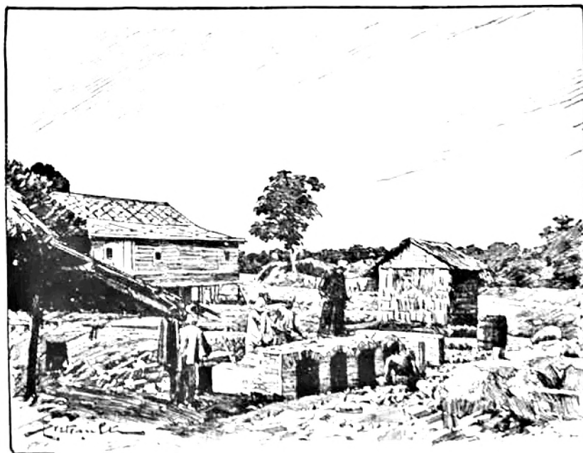
Un poste en construction.
