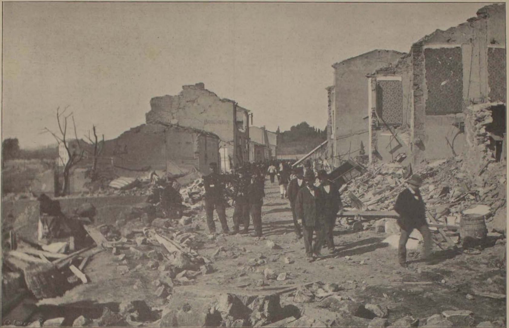
Aspect d'ensemble du village de Lagoubran après l'explosion. — (Phot. M. Bar.)
