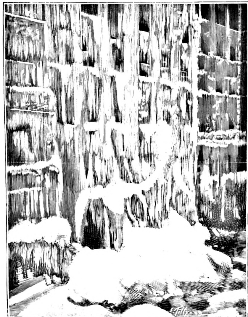
Maison incendiée couverte de glaçons produits par l'eau des pompes.
