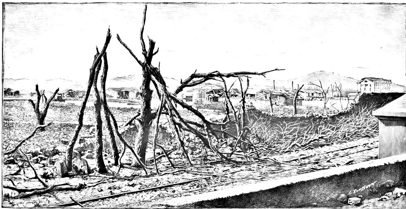
Effets de l'explosion sur des arbres situés aux environs de la poudrière N° 1. — (Phot. M. Bar.)
