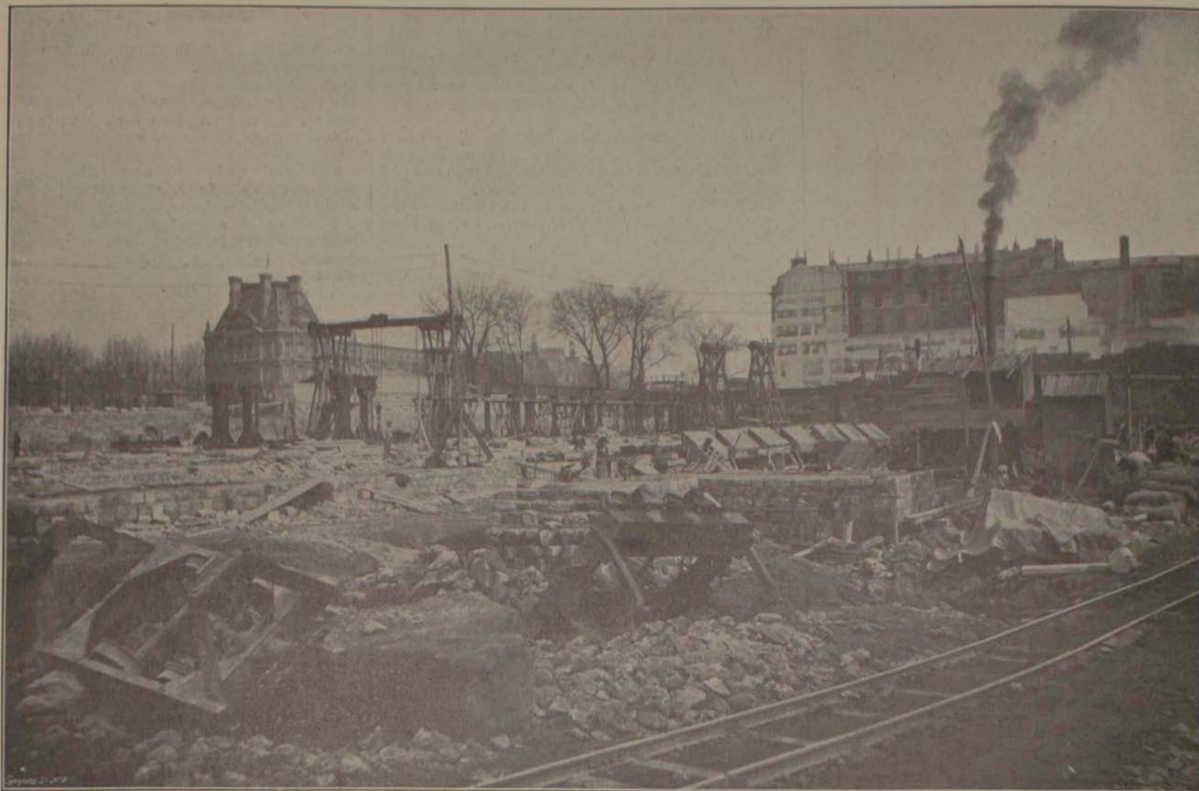
Les travaux de la gare d'Orléans : vue générale du chantier de la Cour des Comptes.
