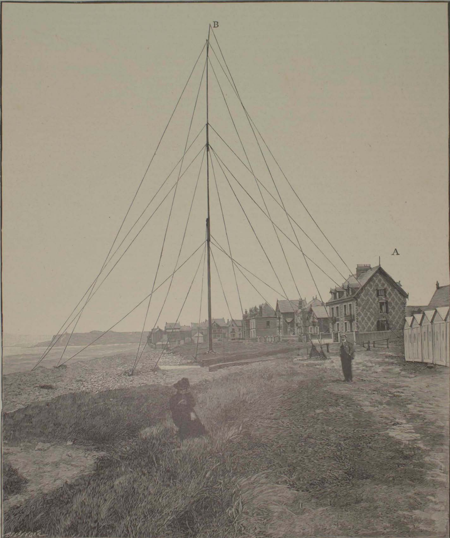
A. Chalet contenant le poste télégraphique. — B. Transmetteur et récepteur des ondes électriques.
