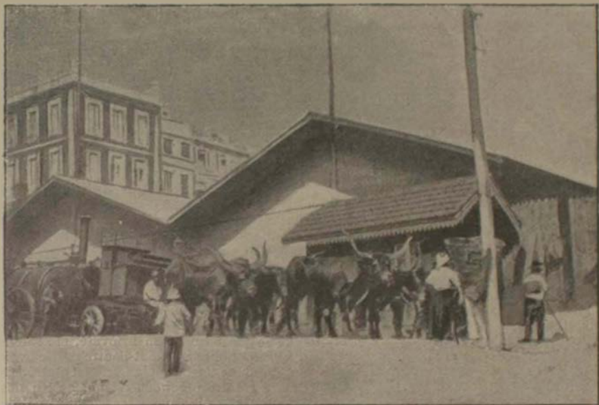
Le transport de l'appareil à désinfecter.
