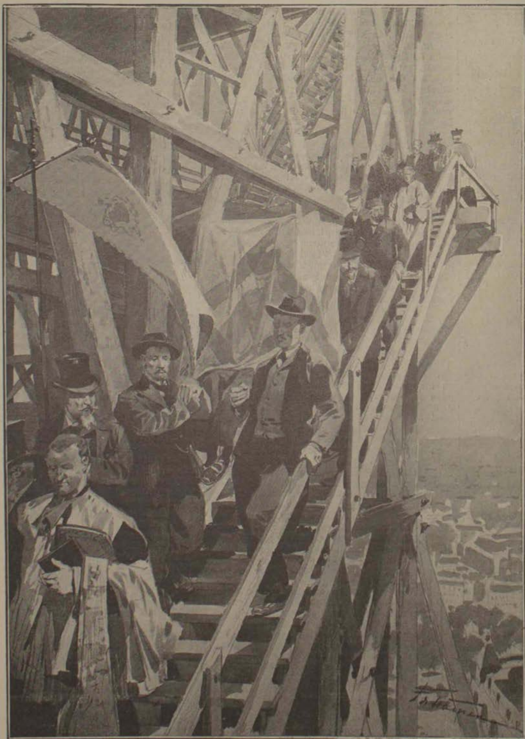
La chaise à porteurs de l'archevêque sur l'échelle extérieure des échafaudages
