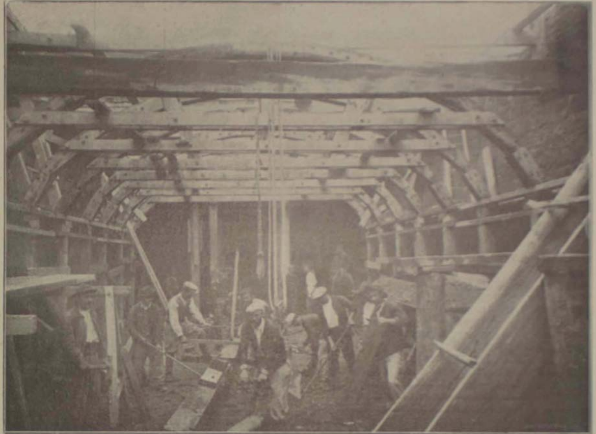
Chantier à ciel ouvert, au quai Malaquais.
