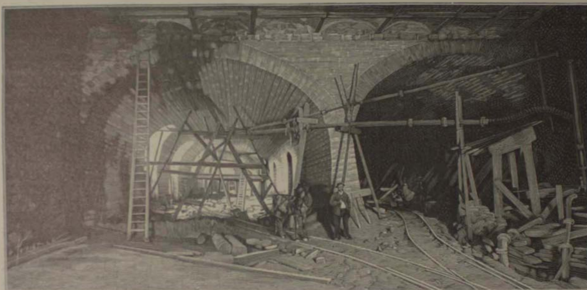
La double voûte en maçonnerie sous le quai Voltaire.
