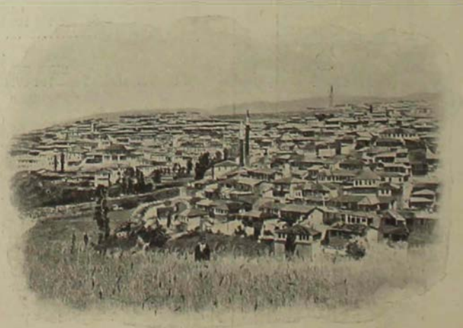
Vue générale de Demirdjick.
