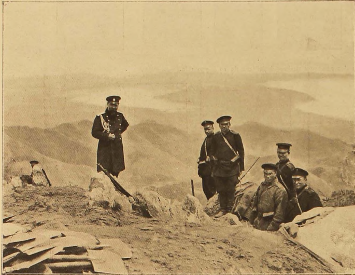
Le général Kondratchenko surveillant les travaux de mines sur la colline du Loup.
