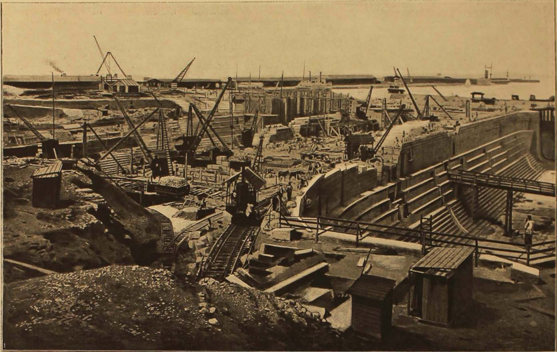
Les chantiers de construction des bassins de radoub à Gibraltar.
